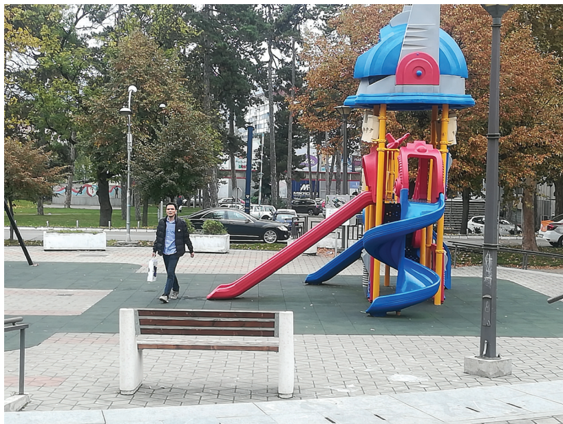
Slika 17. Izgradnja dječjeg igrališta na betonu
