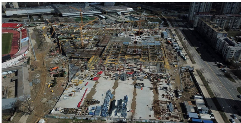
Slika 2. Izgradnja TC Promenada u Novom Sadu. Izvor: NS Build. Mart 2018.
